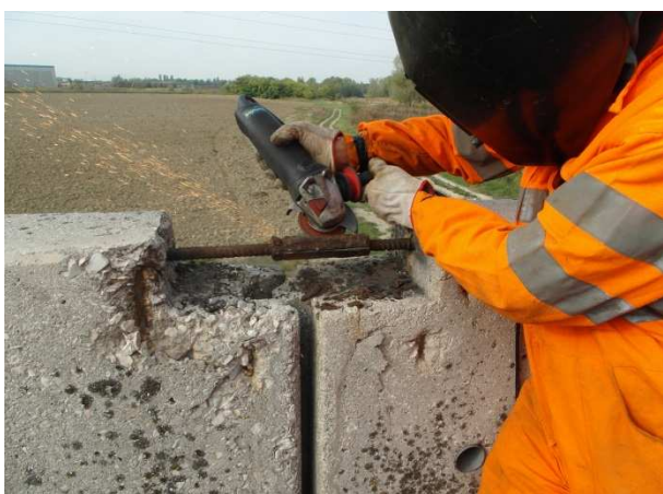
Fig. 3: Taglio del manicotto deteriorato.
