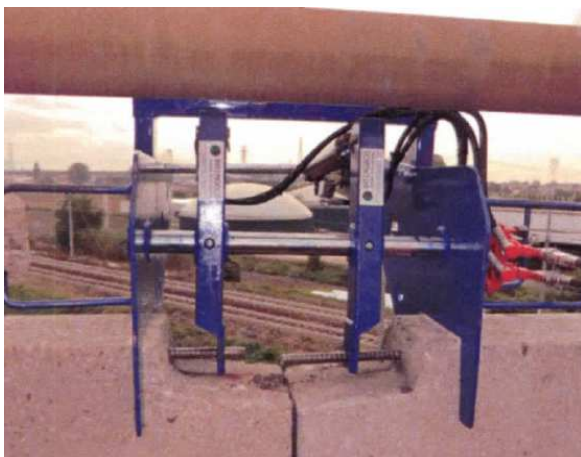
Fig. 7: Disallineamento delle barre dywidag mediante il disassatore dywidag.
