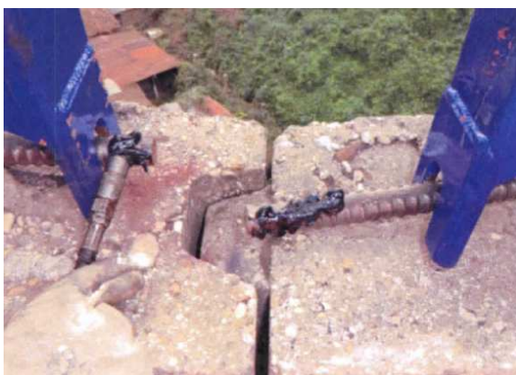
Fig. 8: Ingrassaggio delle barre dywidag e inserimento del nuovo manicotto di collegamento.
