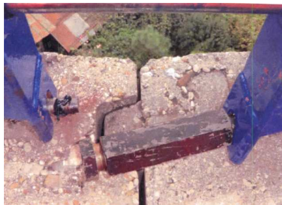
Fig. 8: Ingrassaggio delle barre dywidag e inserimento del nuovo manicotto di collegamento.
