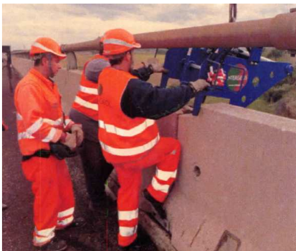
Fig. 6: Posizionamento del disassatore dywidag.
