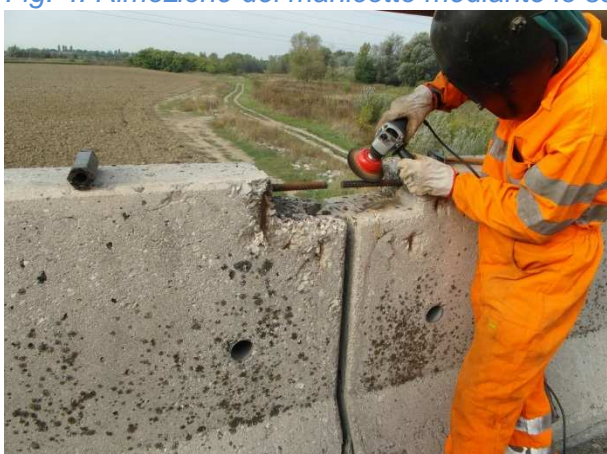
Fig. 5: Ravvivatura della barra dywidag.
