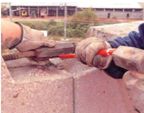
Fig. 4: Rimozione del manicotto mediante lo scalpello.
