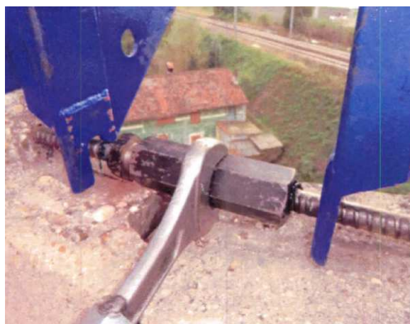
Fig. 9: Riallineamento delle barre dywidag e serraggio del nuovo manicotto di collegamento.
